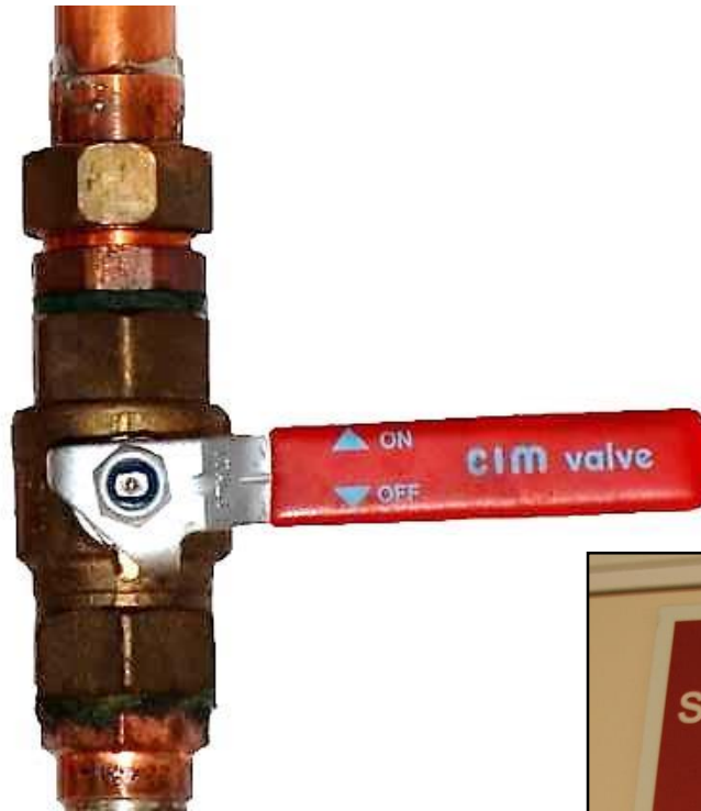
Foto: SINTEF Byggforsk
