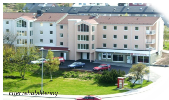
I Svingen kommunale blokkleiligheter for rusmisbrukere, var målet for prosessen å gi beboerne mestringfølelse og innflytelse i egne boforhold. Leilighetene ble pusset opp og fikk egne bad, og dørene til de to oppgangene ble låsbare. Dette gav trygghet og verdighet.
