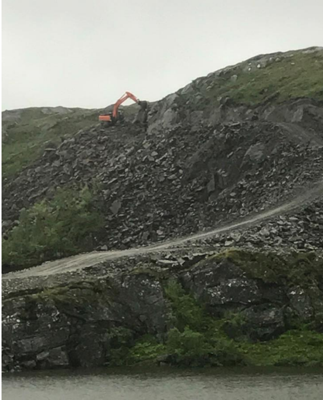
Figur 4. Etablering av anleggsvei, Roan vindpark.
