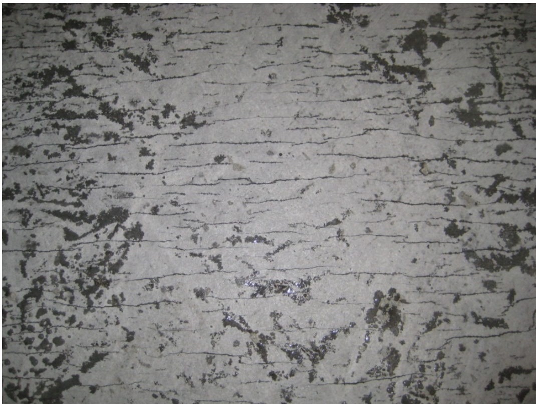
Figur 21. Eksempel på riss i ok bunnplate pga. temperaturdifferanser over tverrsnittet. Fra vinterstøp med isolasjon på overflaten etter støp, men isolasjonen ble fjernet ved en feil etter ett døgn. Foto: Statens vegvesen
