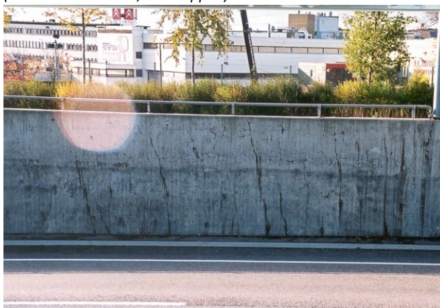
Støttevegg fastholdt mot bunnplate (Foto: S. Helland, Skanska)
