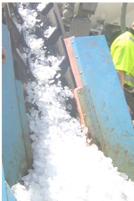
Figur 16. Is brukt til kjøling av betong
