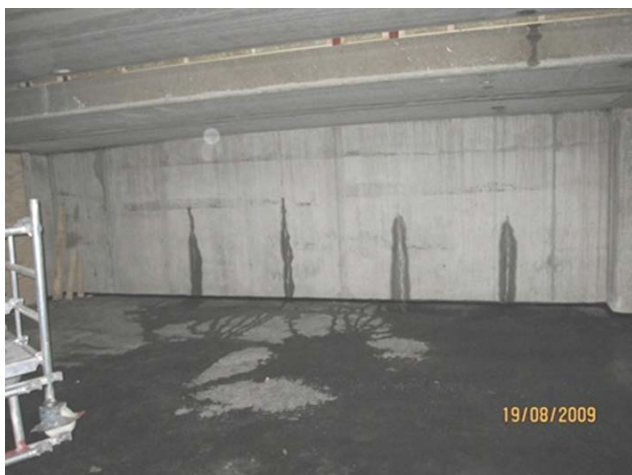
Garasjevegg fastholdt mot bunnplate (Foto: B. Kristiansen, AF Gruppen)
