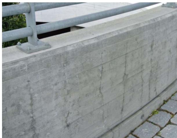
Kantbjelke fastholdt mot brudekke (Foto: Skare og Stemland, NTNU)
