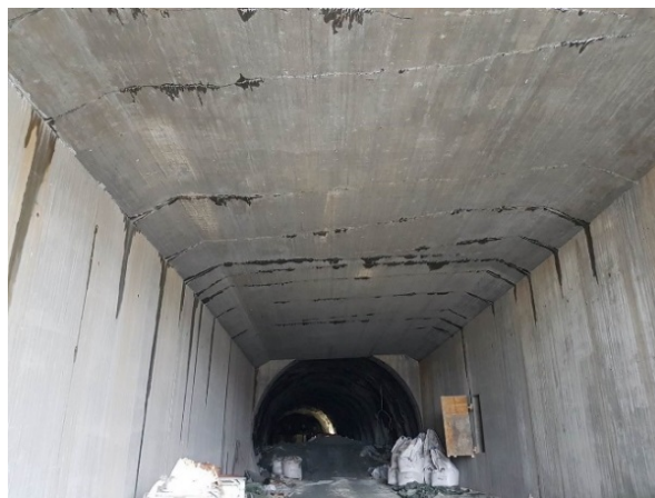
Toppdekke fastholdt mot to vegger (Foto: Statens vegvesen)
