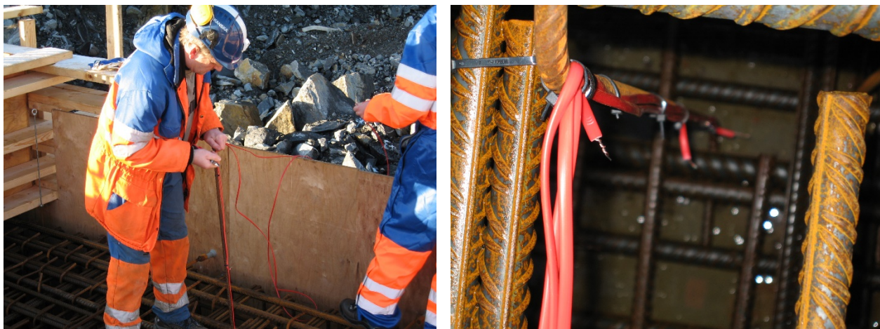
Figur 19. Bunnplate: Eksempel på montering (venstre) og endelig plassering (høyre) av termoelementer i tre nivåer på armeringsbøyle. (Foto: Statens vegvesen)
