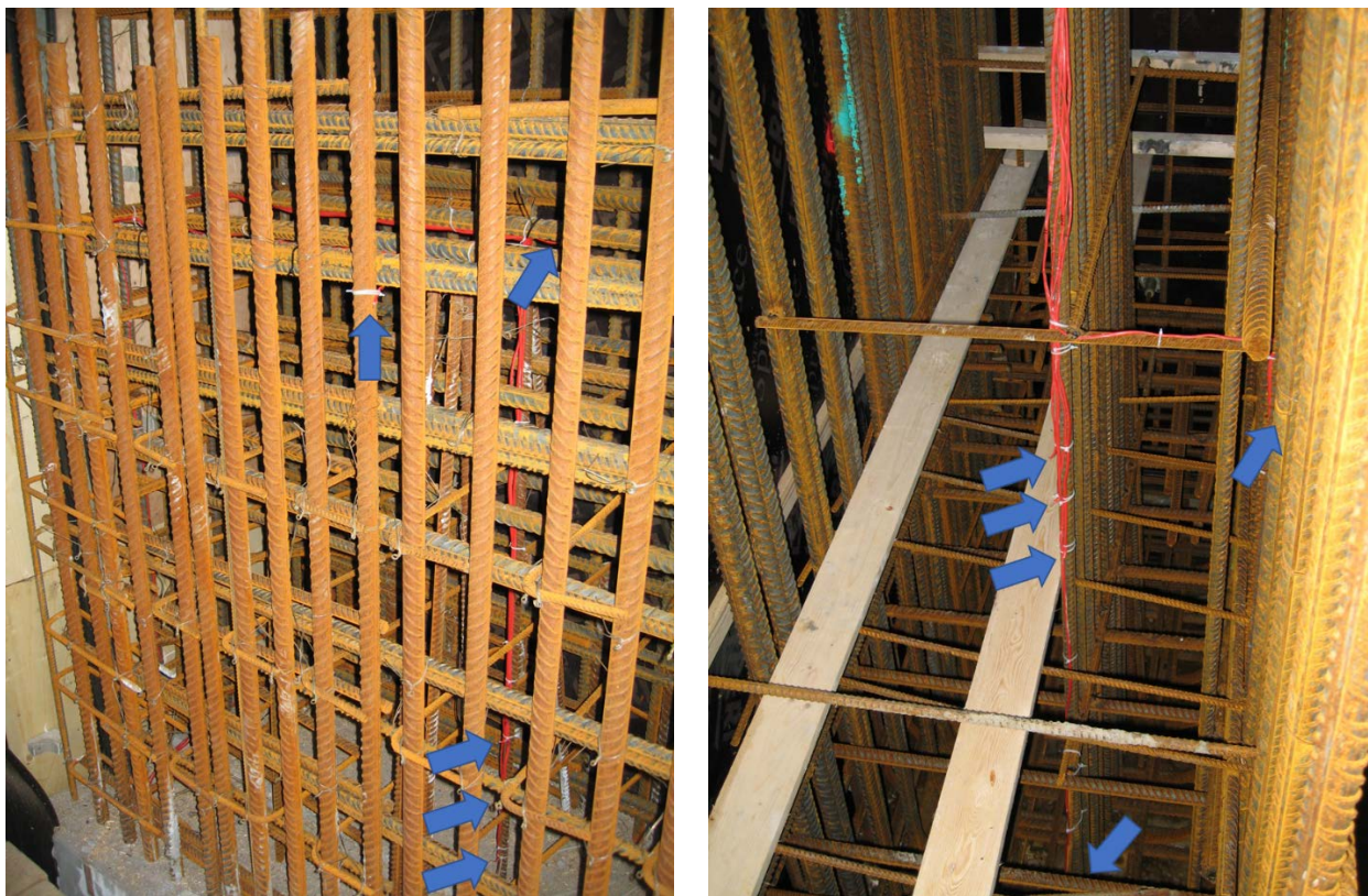
Figur 20. Vegg: Eksempler på plassering av termoelementer og målepunkter (piler) i to vegger. (Foto: Statens vegvesen)
