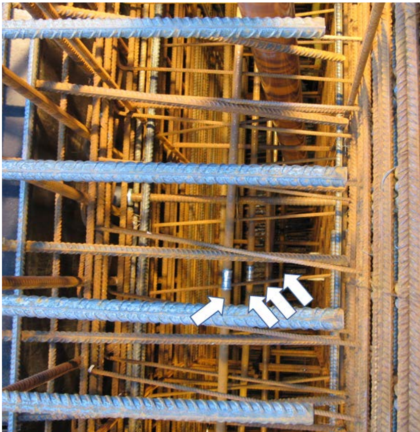
Figur 17. Eksempel på monterte kjølerør (piler) over hele vegg høyden, sett ovenfra og ned. Kun de fire øverste kjølerørene i vegg ses på bildet.
