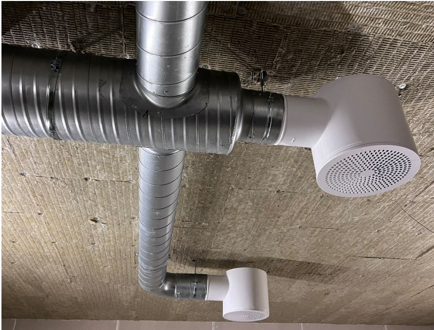
Figur 2-4: Ventilasjonskanaler montert hengende fra taket.
