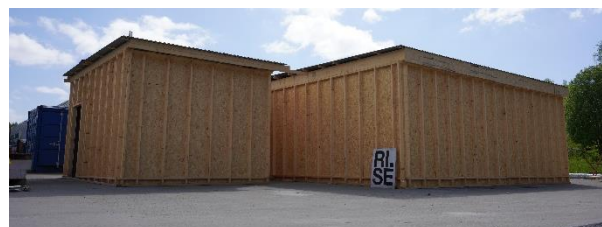
Figur 1: Testbygget som inneholdt en korridor, et arbeidsrom og et klasserom. Foto: RISE Fire Research.
