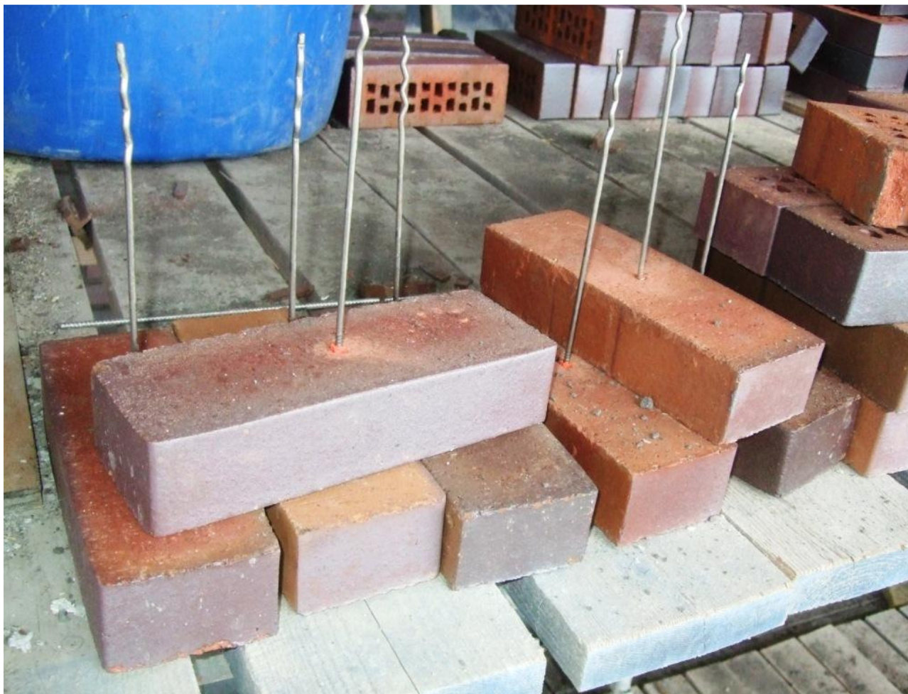
Bunnskiftet utføres av massivtegl med vertikal ankerstang fastgyst i utboret hull.
