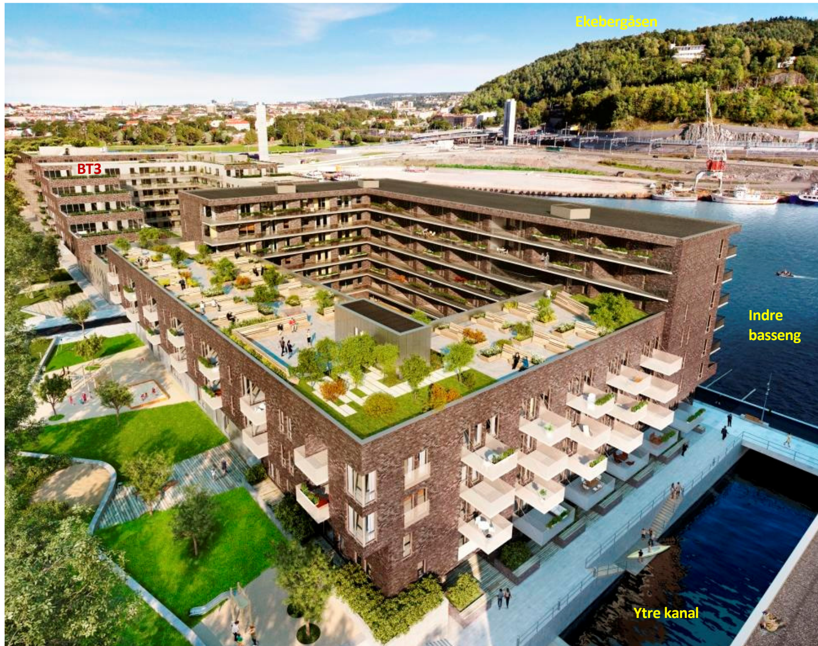
Bilde 4.1 BT4 sett fra vest med Indre park t.v. og Indre basseng og Ytre kanal t.h. på bildet.
