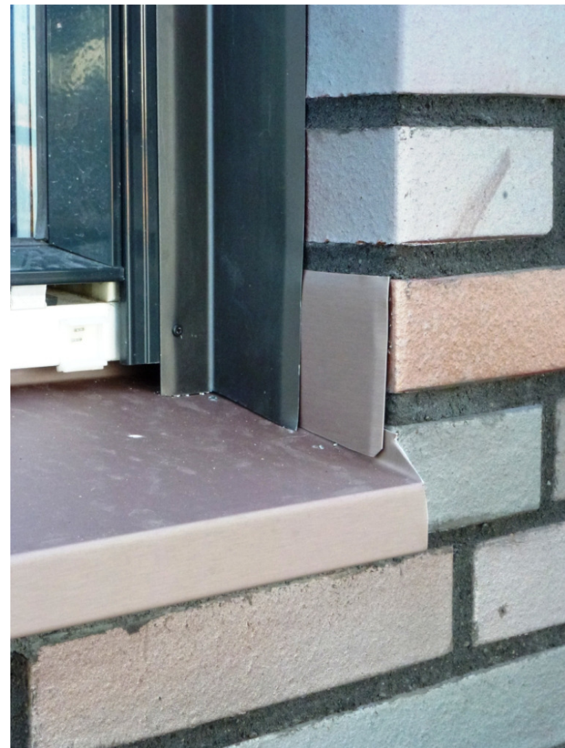
Fig. 3: Sjørega, BT 1. Eksempel på vindusinnsetting og beslagløsning i sålbenk, sidefals og toppfals på Sjørega. Separat endelokk i sålbenkbeslaget utføres med innfuget, smal vannfals og limes til sidefals med spesielt fugelime.
