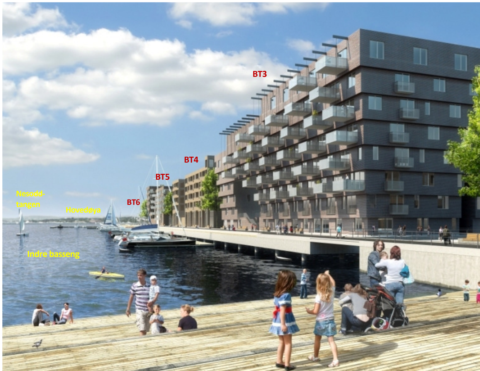
Bilde 3.2: SØ-fasade, kaipromenade mot Indre basseng. Begge hjørnefasader mot SØ og NØ har trinnvis utkraging på ca. 0,5 m for hver etasje. Teglfasadene i hver etasje har opplegg på stålvinkel utkraget fra betongdekke.
