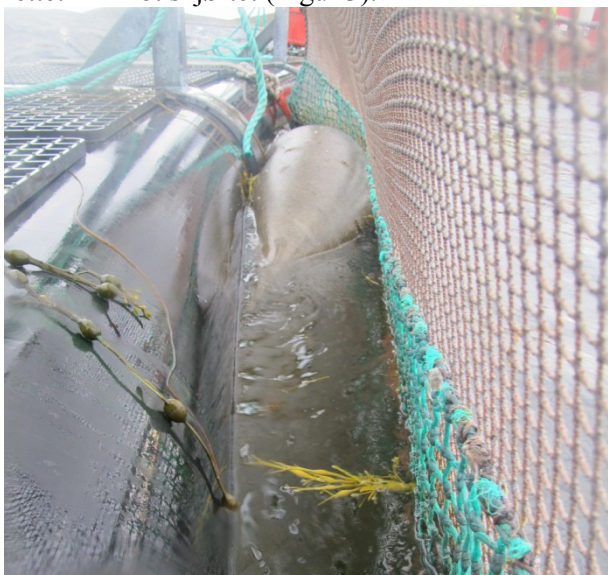
Figur 2 Luftlomme i skjørtet på innsiden av flytekragen.
