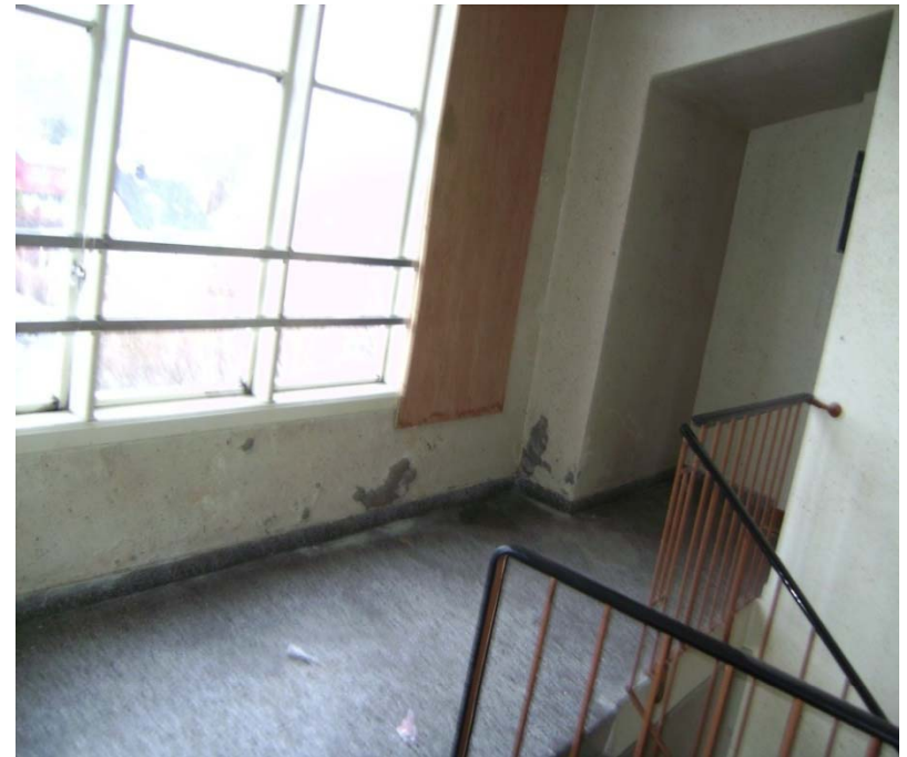
Trapperom før rehabilitering.
