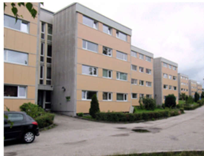
Tinnbo Borettslag i Kristiansand. 114 leiligheter er rehabilitert og blitt lavenergiboliger. (Foto:Sorbbl)
