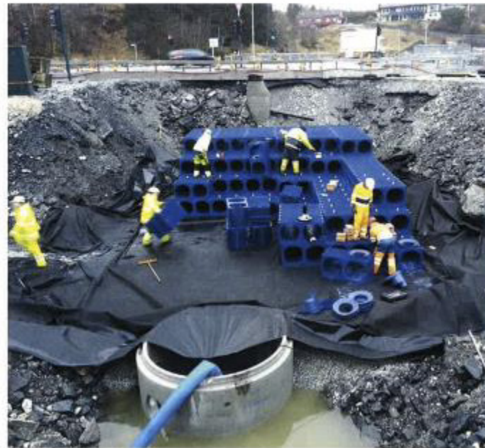
Fordrøyningsanlegget ble bygget ved hjelp av plast-kassett systemet Q-bic.
