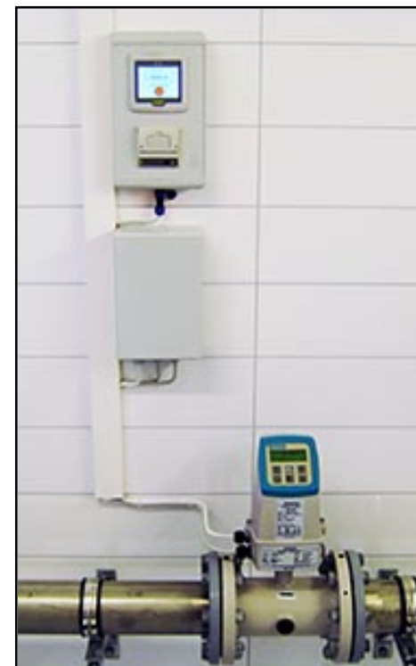
MAG 5100W DN 150 PN 16 Elektromagnetisk vannmåler med display.
