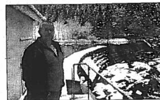
STEMMA: Arild Stammen, driftsjef i Dale, ved stemma der dynamittladninga vart sprengt.
