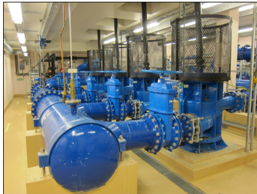
Kjeller: fire pumper
