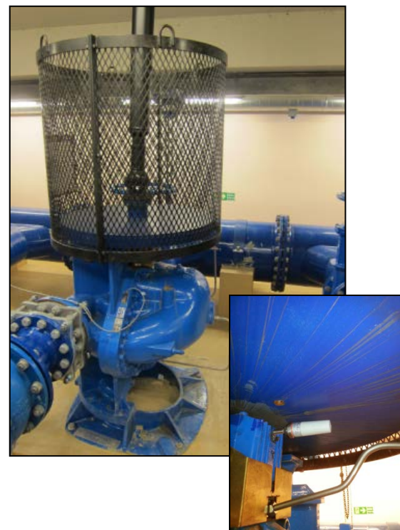
En sensor på hver pumpe
