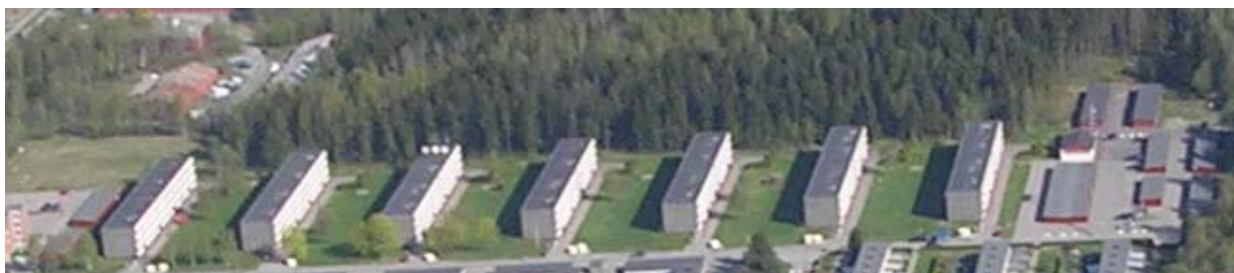
Figur 1: Myhrerenga borettslag: sju lamellblokker og felles fyrhus
