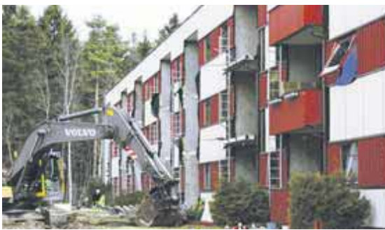
FOREGANGSPROSJEKT. Myhrerenga borettslag er det første blokkprosjektet i Norge som oppgraderes etter passivhuskonseptet. FOTO: ALEX BRAATHEN
