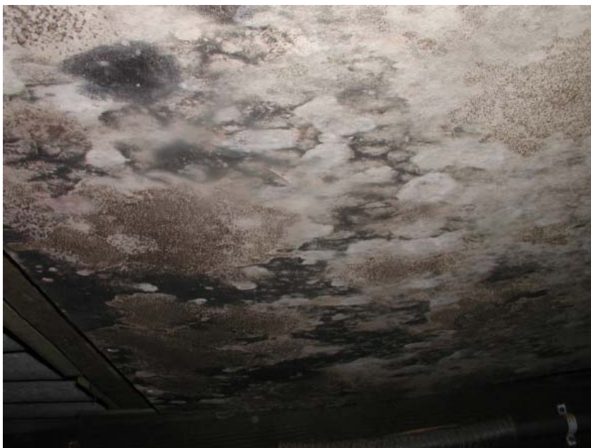
Figur 5: Slike omfattende muggsoppskader i krypekjellere blir ofte oversett,
