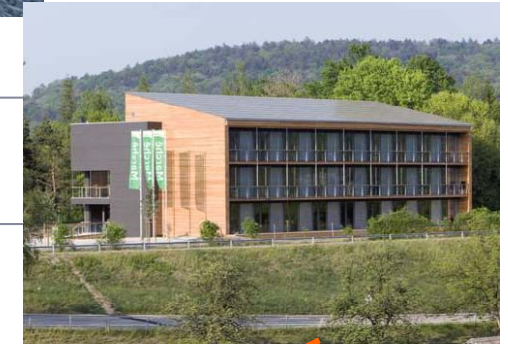
Marche kontorbygg - Nullenergibygg -
