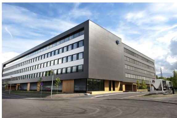
Syd og vestfasade, reversible luft/ vann-varmepumper plassert på bakkeplan. Foto: Jan Lillehamre
