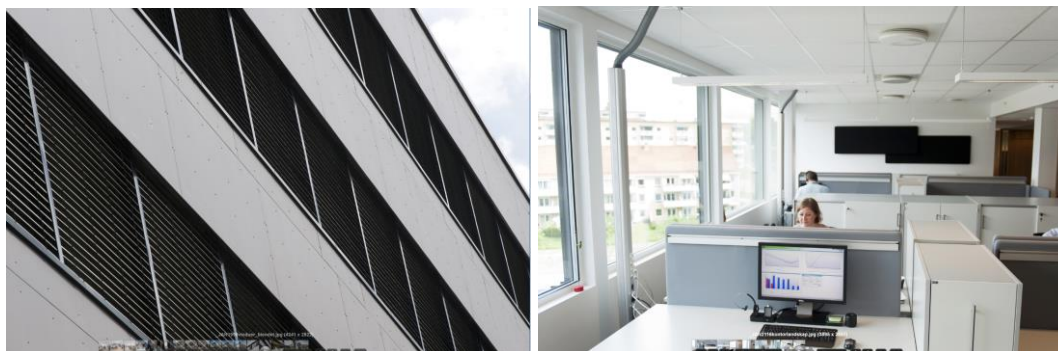
Utvendig solavskjerming og typisk kontorlandskap med grenstav med elektrisk element. Foto: Jan Lillehamre
