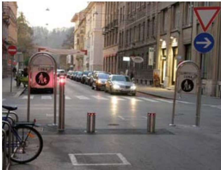
Figur 2: Hevbare pullerter for adgangskontroll (START).
