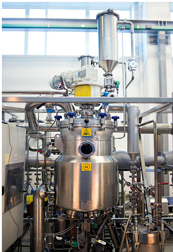
Foto: SINTEFs raffineringsanlegg for marine oljer
