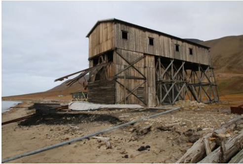
Taubanestasjonen in Hiorthhamn
