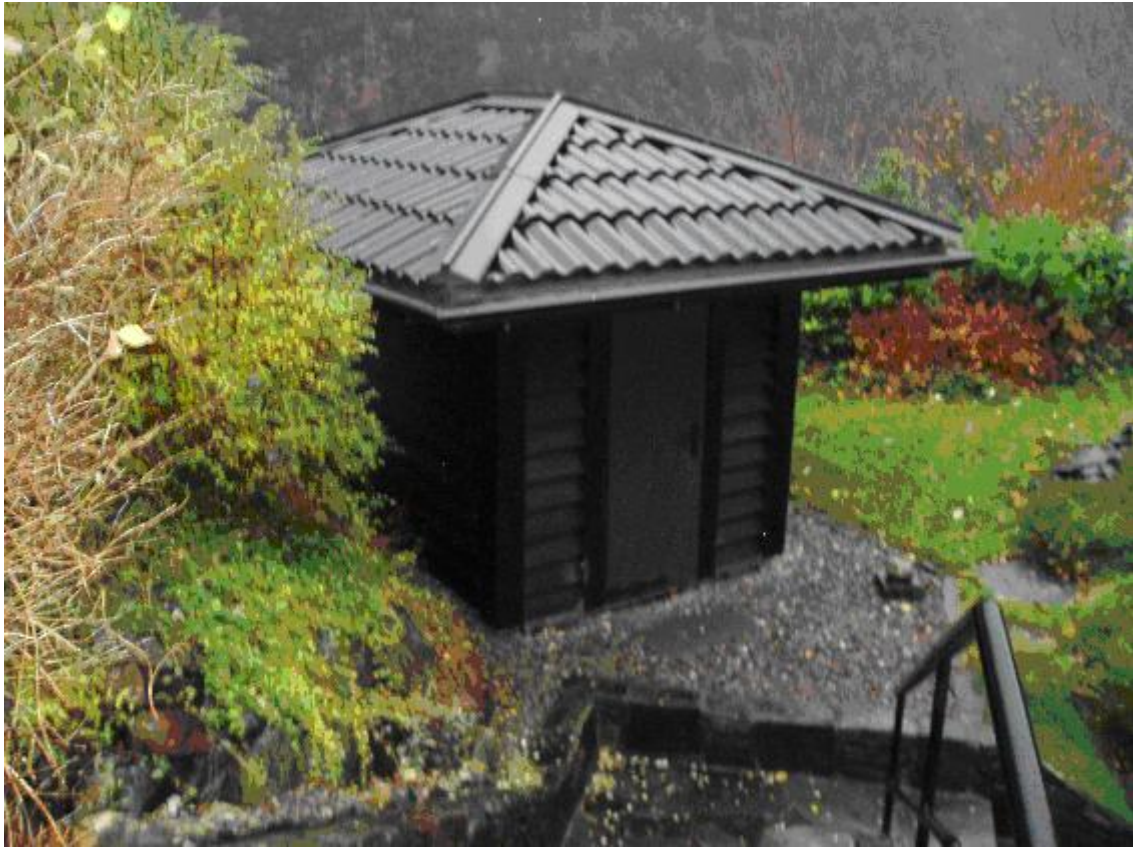
Figur 19 Privat pumpestasjon i nedslagsfeltet til Svartediket (Foto: Bergen Vann KF, nov 2004).
