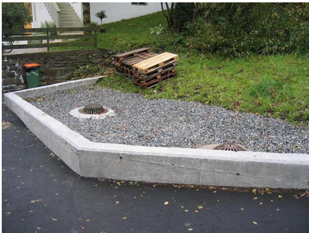
Figur 31 Avskjærende overvannssystem ved Tarlebøvegen
