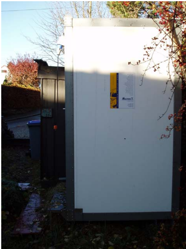
Figur 22 Anleggstoalett ved vannledningsgrøft fra Svartediket – Starefossvegen
