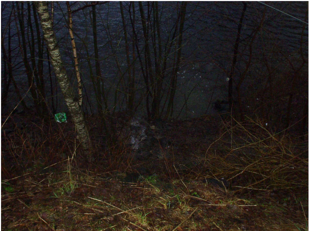
Figur 23 Utslipp stikkrenne under Tarlebøvegen/Svartediket høsten 2004 (foto: Bergen Vann KF).
