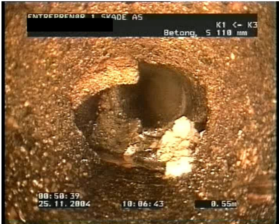
Figur 24 Eksempel rørinspeksjon av private avløpsledninger i/ved nedslagsfeltet til Svartediket november 2004 (foto: Tertnes entreprenør)
