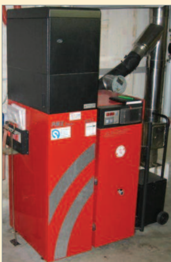
Figur 4.31 Sentral biopellets-kjel som produserer varme til tappevann og romoppvarming i et passivhusprosjekt i Østerrike.
