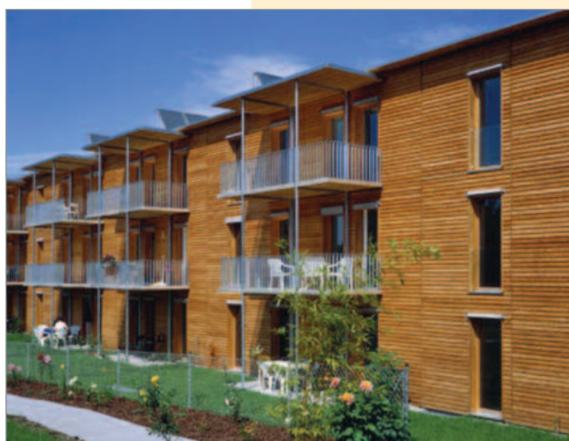
Figur 7.16 Vest fasade. Man skimter solfangerinstallasjonene på taket
