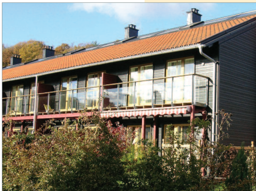
Figur 7.1 Syd fasade rekkehus.
