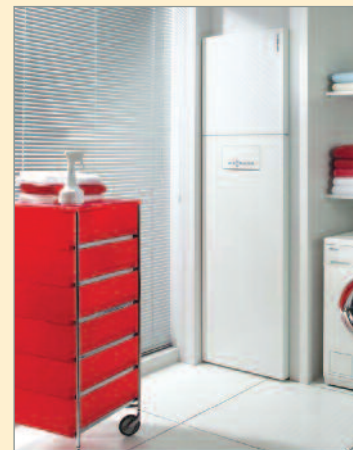
Figur 4.36 Kompaktenheten plassert på vaske- rom, der varmetap fra enheten også kan nyttiggjøres til romoppvarming. Bilde: Viessmann Werke GmbH.
