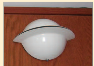
Figur 4.30 Tilluftsventil type: "Frog mouth" ("froskemunn") som brukes mye i passivhus med kun luftoppvarming.
