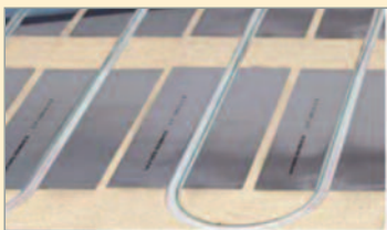
Figur 4.28 Vannbåren gulvvarme i sponplategulv (undergulv av spon)
