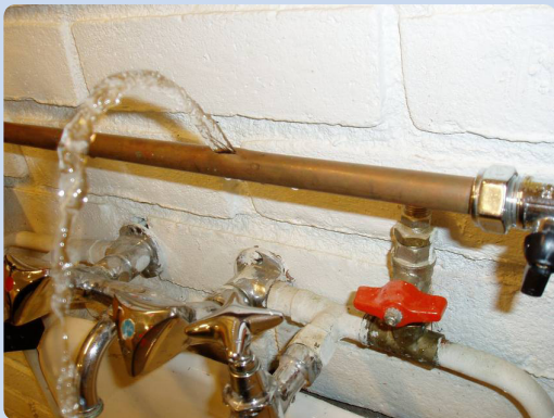
Frostsprengt kobberør
