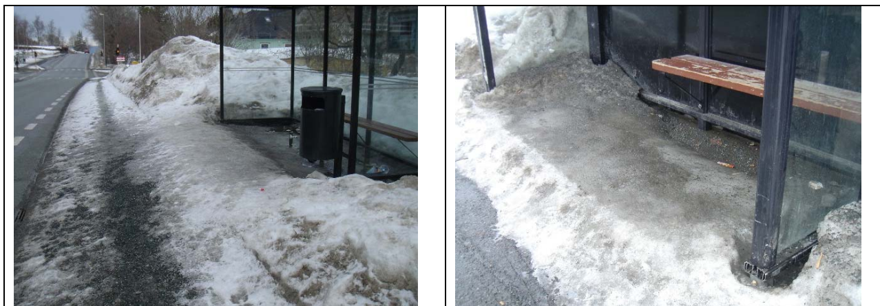
Figur 4.36: Isdannelse i leskur
