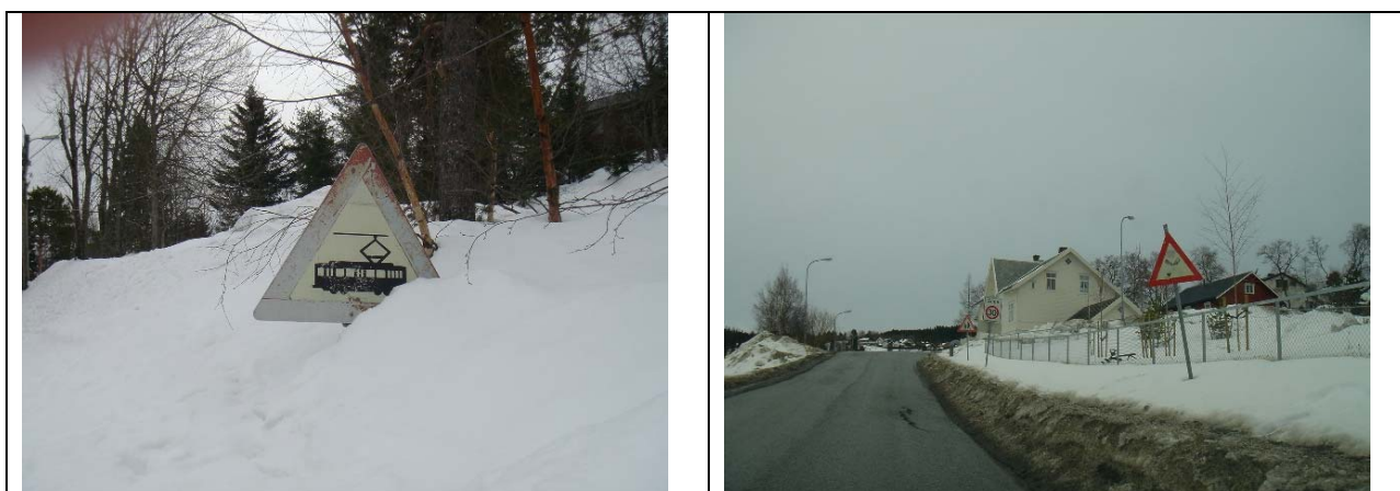
Figur 4.39: Dårlig synlighet av skiltplate
