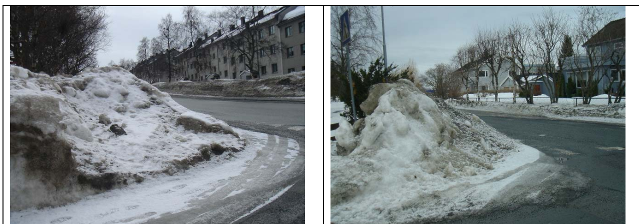
Figur 4.31: Siktbegrensning i T-kryss
