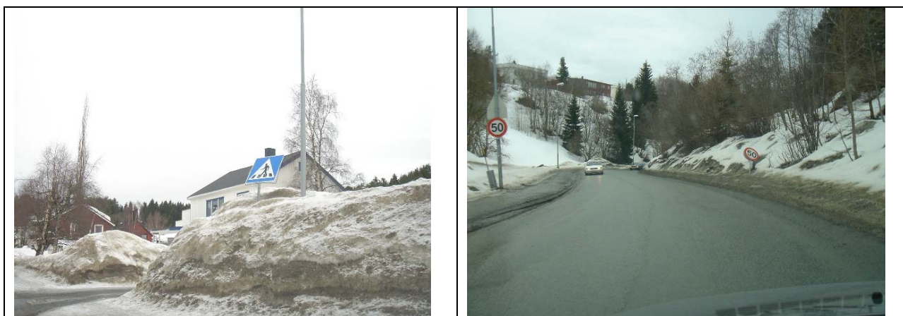
Figur 4.38: Brøyteskader på skilt
