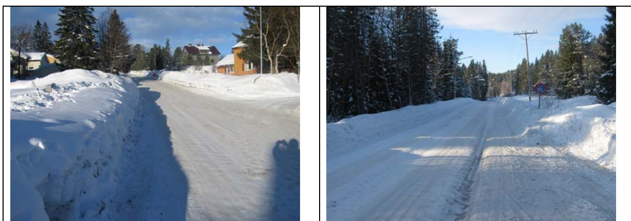
Figur 4.4: Tykk snøsåle i både Uglavegen og i Vådanvegen, samt dype spor i Vådanvegen
