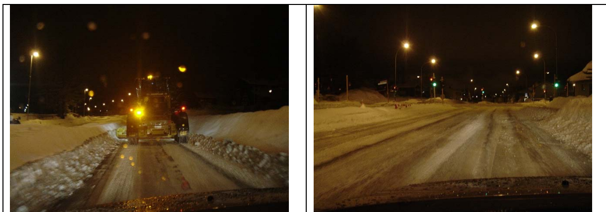
Figur 4.17: Byåsvegen ved Johan Falkbergets veg etter brøytetiltak
