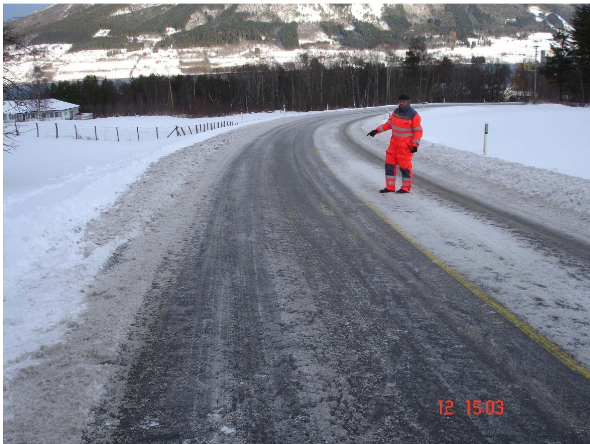
Figur 3.40 Føreforhold etter preparering kl 15:03
