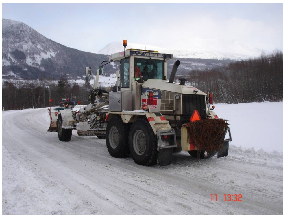
Figur 3.19 Etter vanning ble snø-/isdekket komprimert
