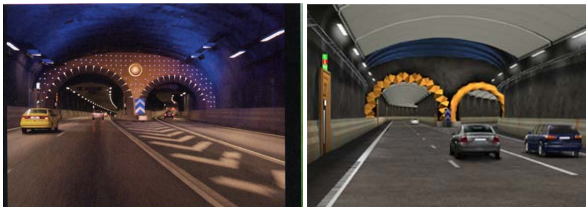
Figur 3-10: Design av kryssløsninger i Stockholmsringen. Til høyre en 3-D modell testet i simulator. Til venstre et bilde av krysset slik det ser ut ved åpning av tunnelen (Sødra lenken).
