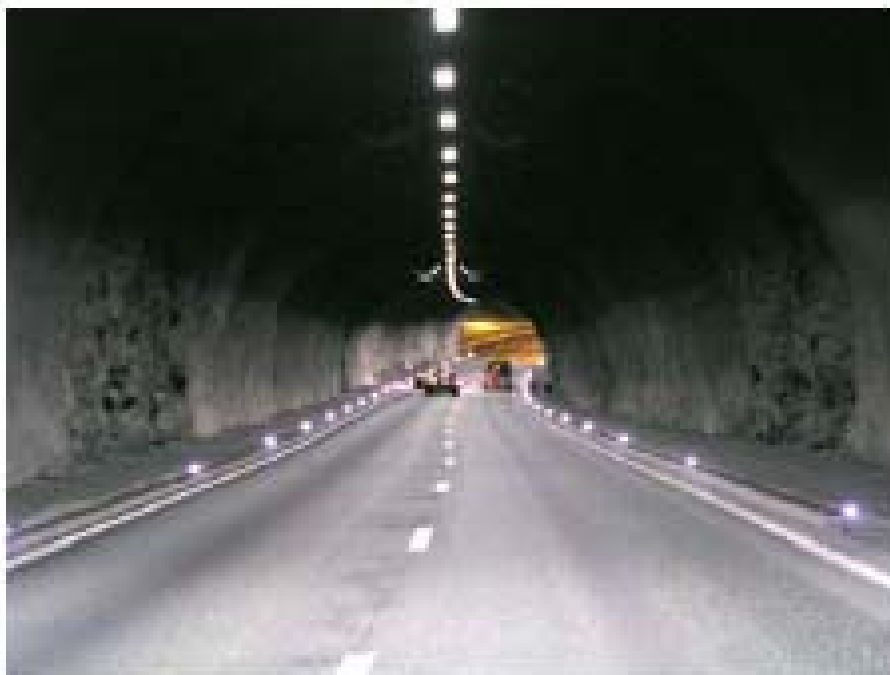
Figur 3-4: LED kantbelysning i Grilstadtunnelen (Kilde SINTEF)
