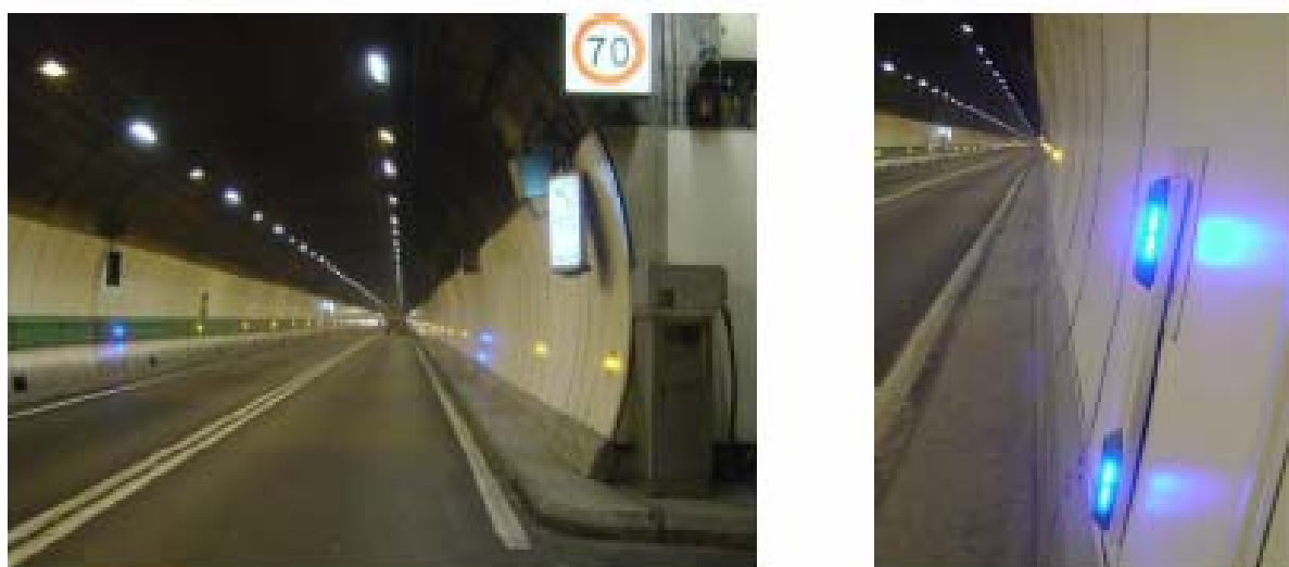
Figur 3-6: Gule og blå LED lys i Mont Blanc tunnelen (Ernst et al.2006))
