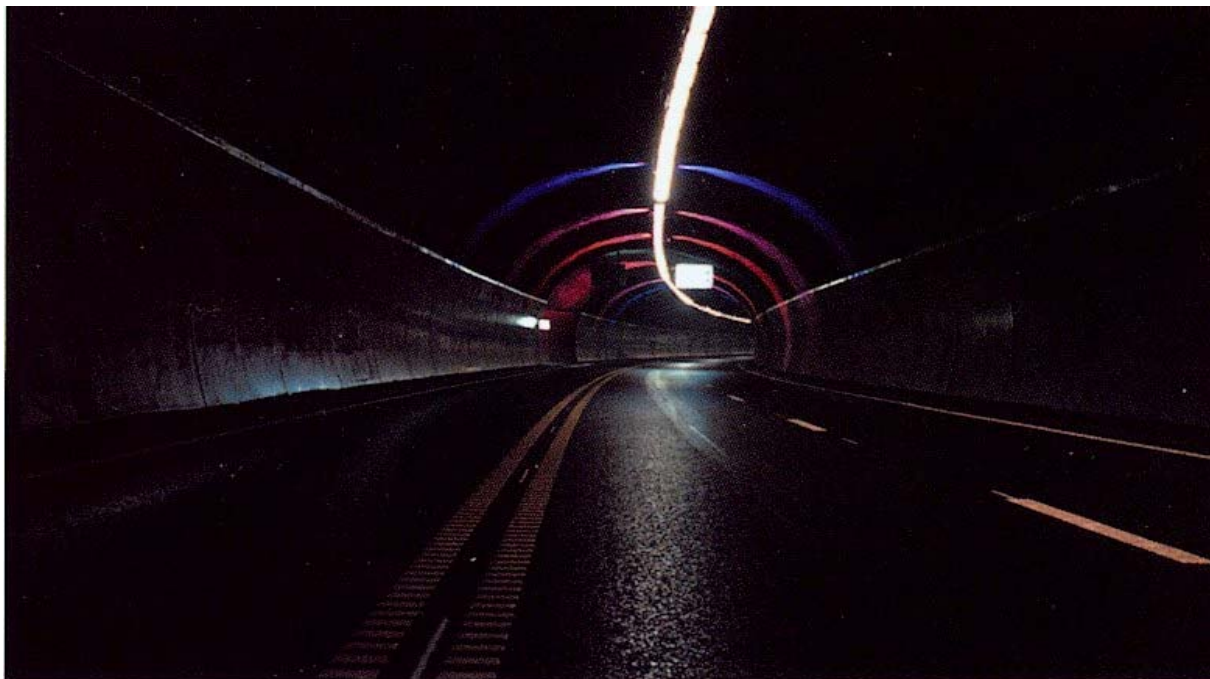
Figur 3-3: Tunnelbelysning i midtpartiet av Oslofjordtunnelen (Kilde Statens vegvesen)
