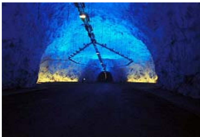
Ved inngang til bergrom
