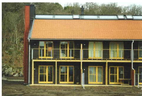
"Hus uten varme". Eksempel på rekkehusbebyggelse utenfor Gøteborg med superiolert bygningskropp, utnyttelse av passiv solenergi, solfanger på taket, balansert ventilasjon med varmegjenvinning og energieffektivt utstyr og belysning. Totalt energiforbruk(ol): 45 – 50 kWh/m 2 år.
