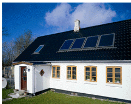
Eksempel på takmontert solfanger fra Velux, som er integrert i takflaten. Figur tatt fra www.velux.dk
