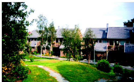
Sjøbadet borettslag hvor romoppvarmingsbehovet dekkes av en sjøvannbasert varmepumpe.
