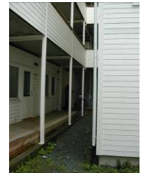
Fra takterasse og svalganger
