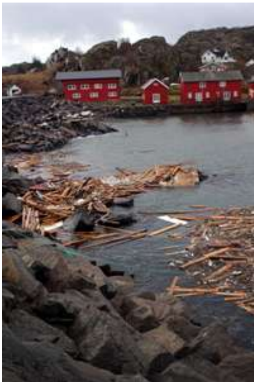
Figur13 Skader etter ekstreme værforhold, sterk vind og høy vannstand (Kilde: www.kystverket.no )
