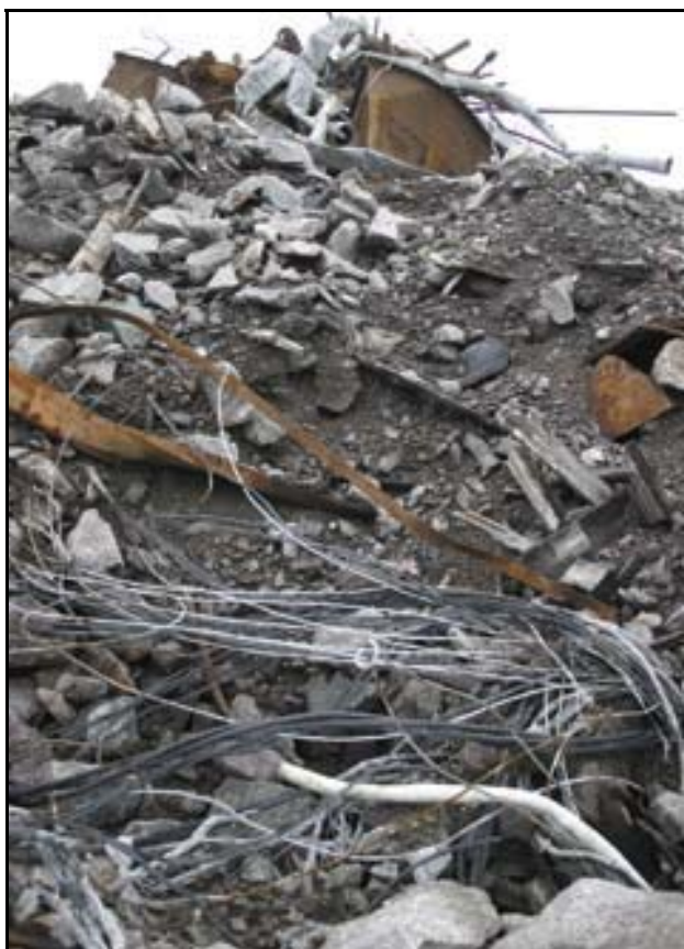
Figur 22 Ved masseuttak fra eldre steintipper, dukker det ofte opp store mengder avfall som er deponert i tippen. Dette må behandles på forsvarlig måte (Hamarsland 2005) [11]
