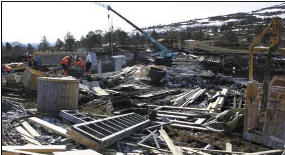
Figur 21 I følge NVEs Veileder nr. 2-05 (Hamarsland 2005) skal håndtering av avfall og forurensning inngå i en HMS-plan eller i egen miljøplan. Målet er en ryddig og sikker arbeidsplass med et minimum av avfalls- og forurensningsproblemer [11]
