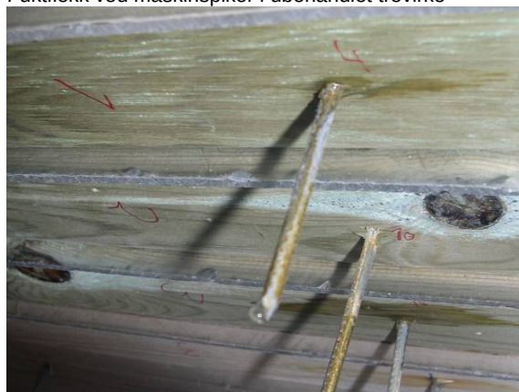
Figur 19 Vanndråper ved maskinspiker i trykkimpregnert materiale
