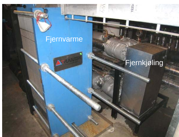
Figur A-13. Rørføring i teknisk rom samt platevarmevekslere for fjernvarme og fjernkjøling. (Foto: SINTEF Byggforsk/ Jørn Stene)
