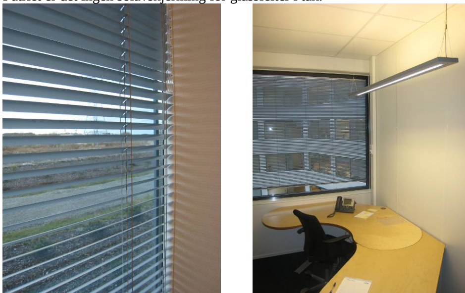
Figur A-11. Solavskjerming med hvite lameller i fasadevindu og innvendig vindu. (Foto: SINTEF Byggforsk/Jørn Stene)
