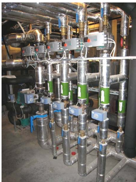
Figur A-13. Rørføring i teknisk rom samt platevarmevekslere for fjernvarme og fjernkjøling. (Foto: SINTEF Byggforsk/ Jørn Stene)
