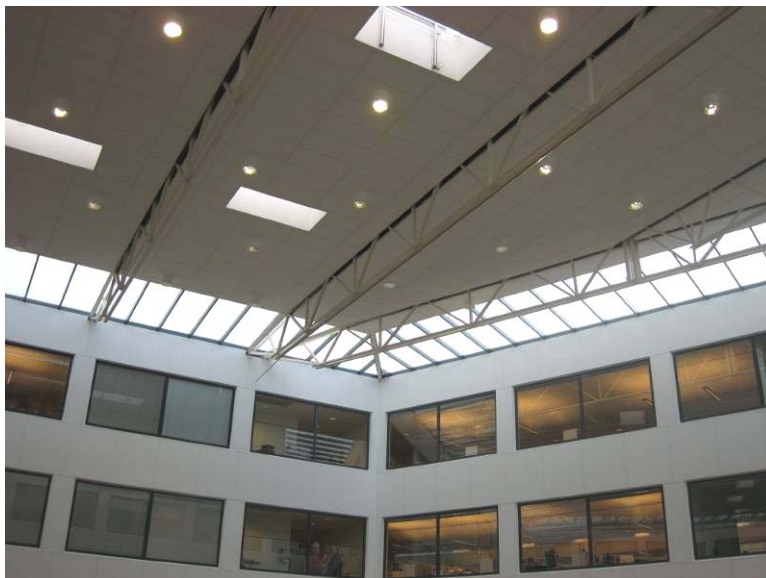
Figur A-8. Tak og vinduer over atriets. (Foto: SINTEF Byggforsk/ Jørn Stene)
