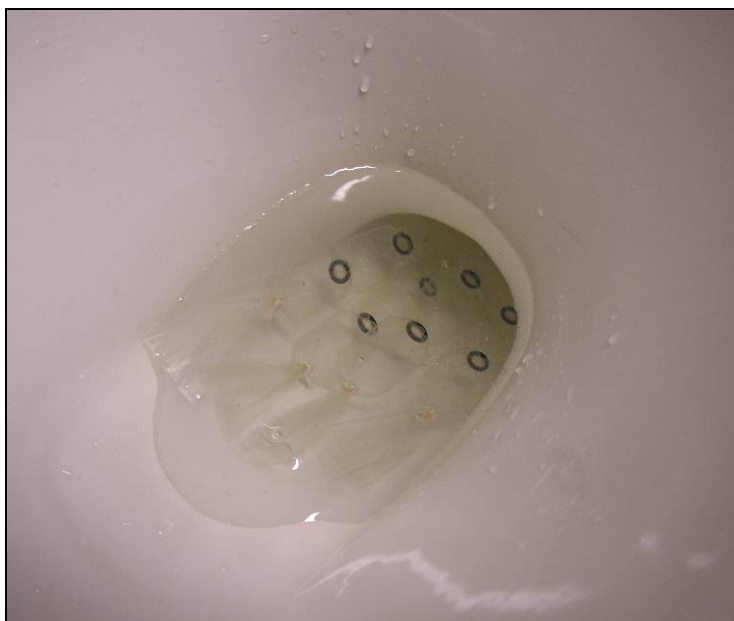
Foto 8: Plassering av spylegjenstand i klosettskålen før spyling
