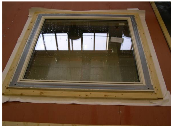
Figur 3.7.2. Vindsperreremse lagt utenpå plate
