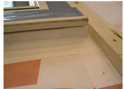
Fig 1.1.3 Vindsperre på rull av polyetylenfibre og tetting rundt vindu med tape
