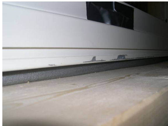
Figur 3.8.2. Fugemasse mot bunnfyllingslist
