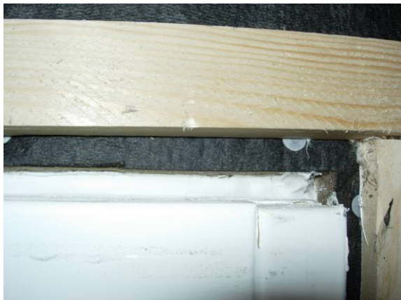
Figur 3.4.1. Fugemasse mot bunnfyllingslist
