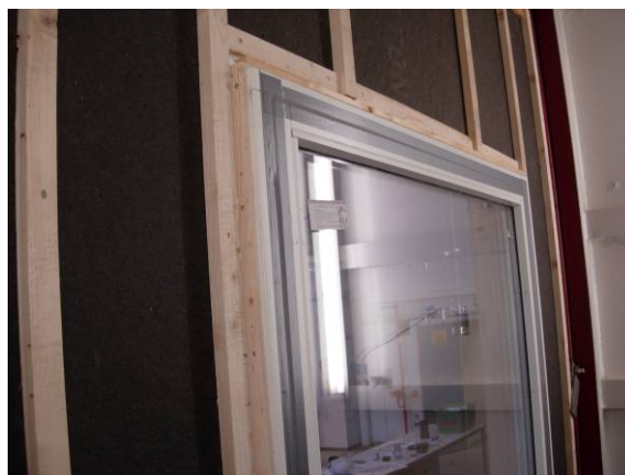
Figur 3.3.2. Vindsperreremse klemmt med lekter mot vinduskarm
