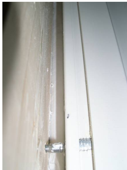
Figur 3.5.4. Tetting i vindsperresjiktet forstyrres ikke av justeringshylsene
