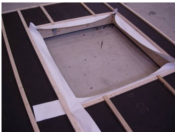
Figur 3.3.1. Vindsperreremse lagt utenpå vindsperreplate rundt vindusutsparing
