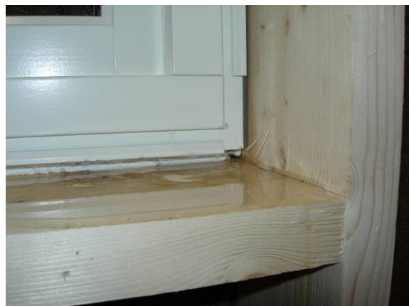
Figur 3.4.4. Når bunnfyllingslisten ble fjernet kunne en se at fugemassen ikke hadde fylt ut i hele fugen
