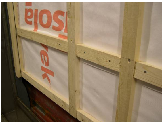
Figur 3.10.1. Detalj fra lekter over vertikal og horisontal skjøt samt lekt ved avslutning på bunnsvill
