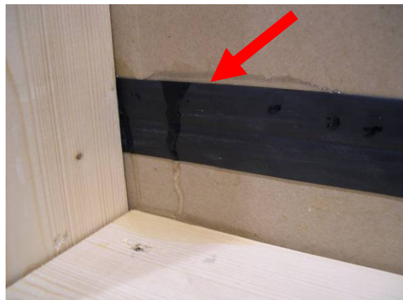
Figur 3.8.4. Vann trenger inn i horisontal plateskjøt med skjøtelist av plast
