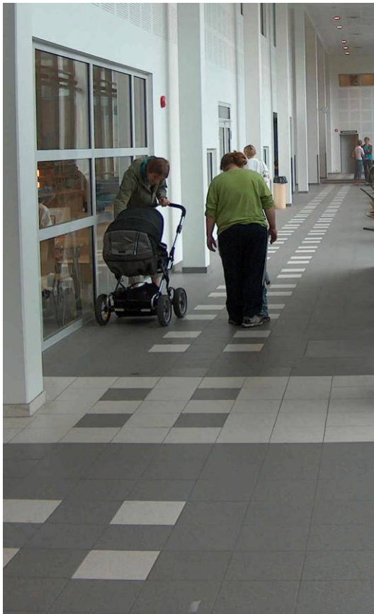
Fig. 24. Bærum sykehus, tilbygg ferdigstilt 2007. Selberg Arkitektkontor AS. Ledelinjer med kontrastfarger er gjennomført i hele tilbygget. Tydelige kontrastmarkeringer og enkelte, men ikke helt systematiske skiller mellom oppmerksomhetsfelt og ganglinjer, for eksempel foran informasjonsskranken på bildet nederst til høyre.
