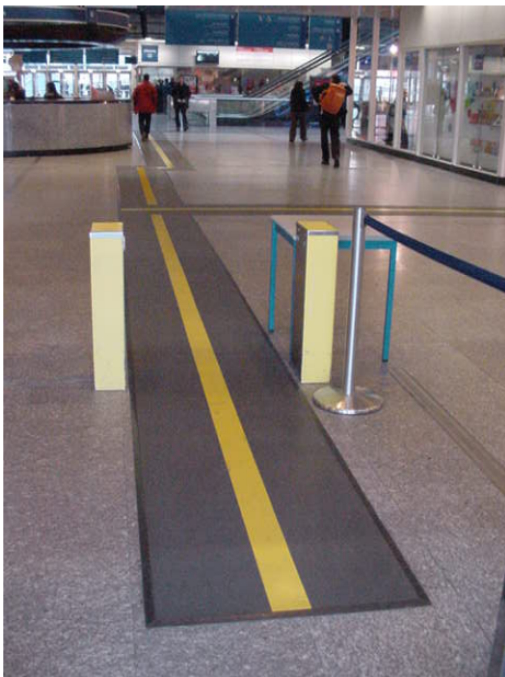
Fig. 47 og 48. Ledefelt i gummi materiale med innfelt ledelinje i kontrast. Oppmerksomhetsfelt har ledelinjen på tvers. Til høyre er et taktilt kart.
