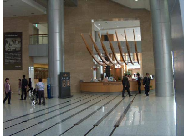
Fig. 16. Ledelinjer i form av kontrastfargede striper kan gå langs eller på tvers av ferdselsretningen. Fra Severance Hospital, Seoul. Arkitekt: Ellerbe Becket, JungLim Architects og Kesson International.
