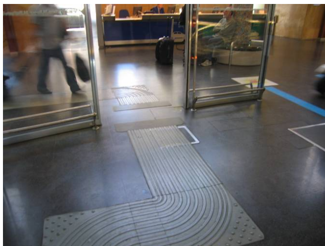
Fig. 39. Eget element for retningsendring, med riller i bue og knoter. Oppmerksomhetsfelt på begge sider av døren
