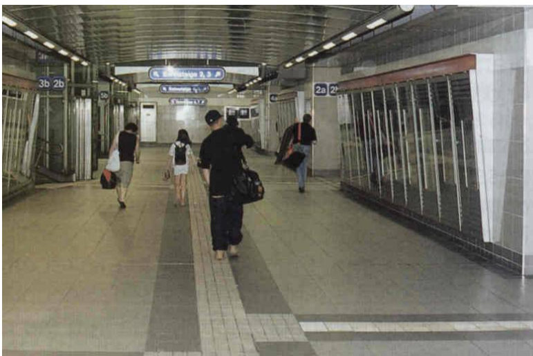
Fig. 10. Graz. Ledelinjer av forsenkede riller og et hierarki hvor de viktigste kommunikasjonsarealene er bredest. (Kilde COST 335)
