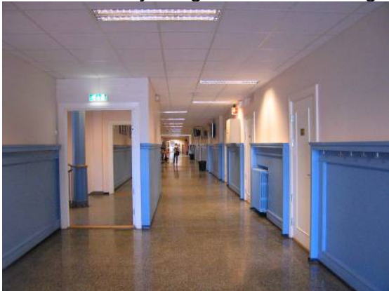
Fig. 29. Korridor på Ullern videregående
