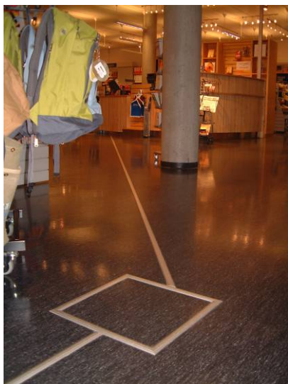
Fig. 62. Universitetet i Agder, Gimlemoen. Underordnet retning vises med en list. Eksemplet viser en ledelinje som treffer oppmerksomhetsfeltet i vinkel. Fig. 63: To parallelle lister markerer hovedretningen. Ledelinjen forholder seg til opprinnelig mønster i gulvet. Foto: Wibeke Knudsen.
