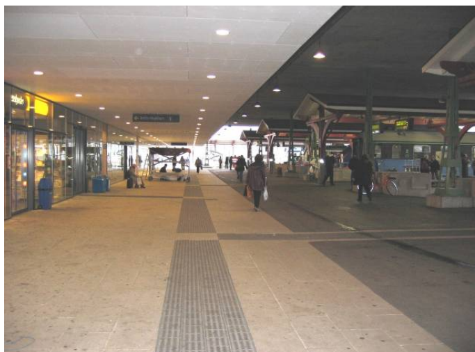
Fig. 34. Ledelinjer til plattformene Foto: Runar Henanger
