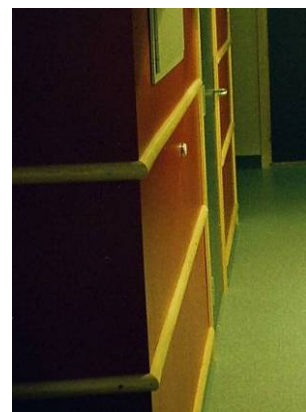
Fig. 30. Kontrastfarger og listverk på en vegg fungerer sammen som ledelinje i helsesenteret på Trysil. Det er imidlertid plassert stoler i korridoren, og det skaper en hindring for synshemmede. Arkitekt: Anderssen og Fremming.
