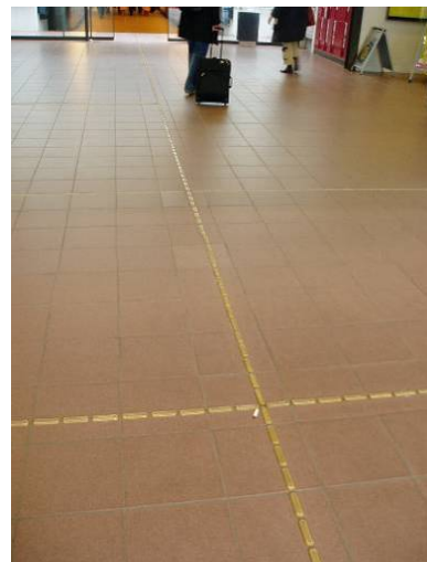
Fig. 70. Vejle trafikktterminal med Pictoform elementer i bronse. Ingen oppmerksomhetsfelt i krysset.
