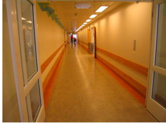
Fig. 28. Fender og høy gulvlist på Rikshospitalet, i tillegg til kantmarkering. Medplan arkitekter as.
