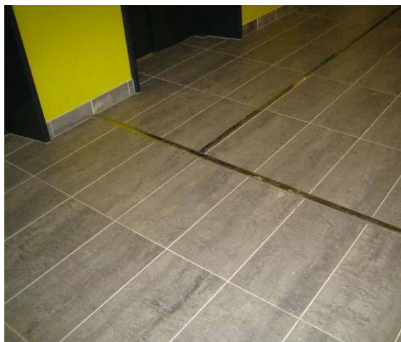
Fig. 43. Sekundære retninger markert med smal list.
