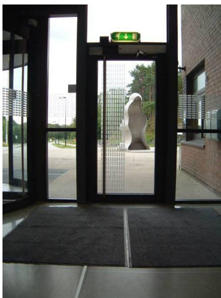
Fig. 50. Høyskolen i Agder. Teppet er lagt over ledelinjen. Foto: Wibeke Knudsen.
