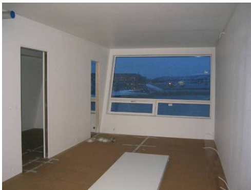
Leilighet i E-bygget under ferdigstilling.
