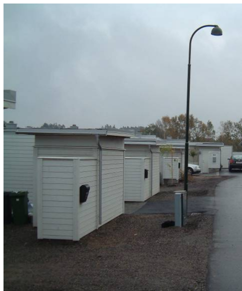
Bodene langs veien
