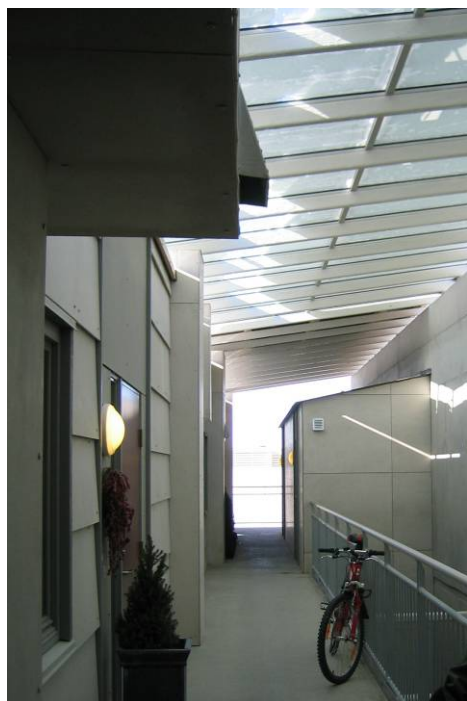
Atkomstsiden med overlys i nedre blokk
