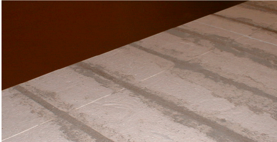
Fig. 15.1 . Varmekabel i spor i EPS-isolasjonsplate med pussmørtel, flytesparkel e.l. med overliggende Al-plate
