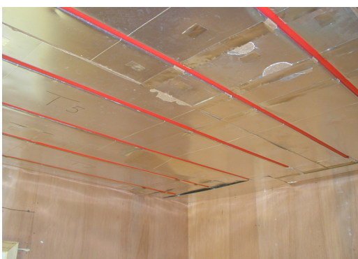
Figur 3.5 b: Takvarme med sentralt plassert tallerkenventil for tilluft. Det er brukt enkelt S-leggemønster for gulv- og takvarmesløyvene og 13 mm gipsplater under 0,5 mm tykke aluminiums varmefordelingsplater.
