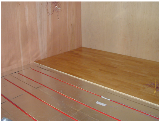
Fig. 3.5 a: Lett utførelse av gulvvarmeanlegg. Det er brukt enkelt S-leggemønster for gulvvarmesløyvene og 13 mm parkett over 0,5 mm tykke aluminiums varmefordelingsplater.
