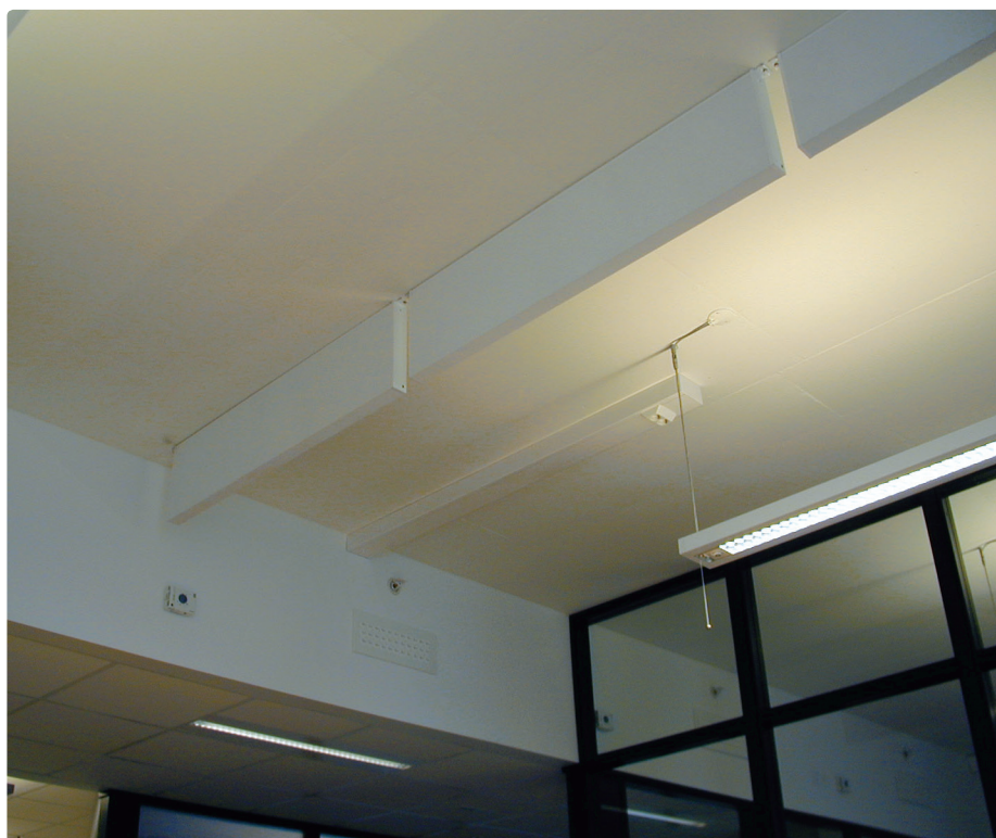
▲ Eksponert betong i tak, kontorareal i Professor Brochs gate 2, Trondheim (Foto: Veidekke)
