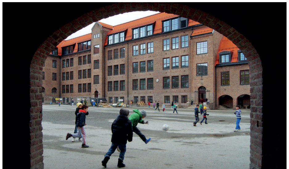
Brandengen skole åpnet i 1914 og er tegnet av arkitekt Arnstein Arneberg. Bygningene har historisk verdi, og Drammen kommune legger stor vekt på å rehabilitere skolen i samsvar med antikvariske myndigheters forventninger. Skoleanlegget består av tre mursteinsbygninger, lenket sammen med arkader. Her ses sørfasaden med nye vinduer og ny takstein. Foto: S. Røgeberg
