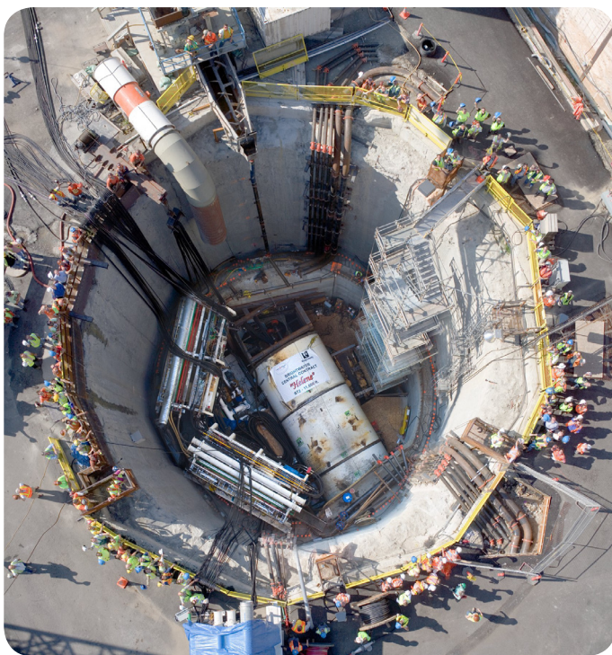
▲ Fra oppstartseremonien for Brightwater BT2 Slurry TBM. Brightwater-prosjektet i Seattle er et av prosjektene i USA hvor den nyutviklede SAT-metoden er benyttet. Prosjektet består av et avløpsrensaneanlegg, avløpstunneler og et undersjøisk utslag. Det ferdige tunnelsystemet vil bestå av ca 25 km med tunneler boret i leire, silt og sand.
