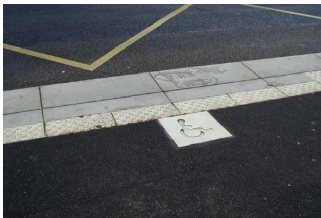
Figur 2: Taktill markering av bussholdeplass og påstigningssted (fremre dør) i Nantes, Frankrike
