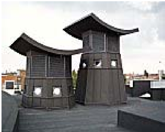
Figur 1 : Avtrekkstårn fra den hybridventilerte IVEG-bygningen i Belgia (kontorbygg).
