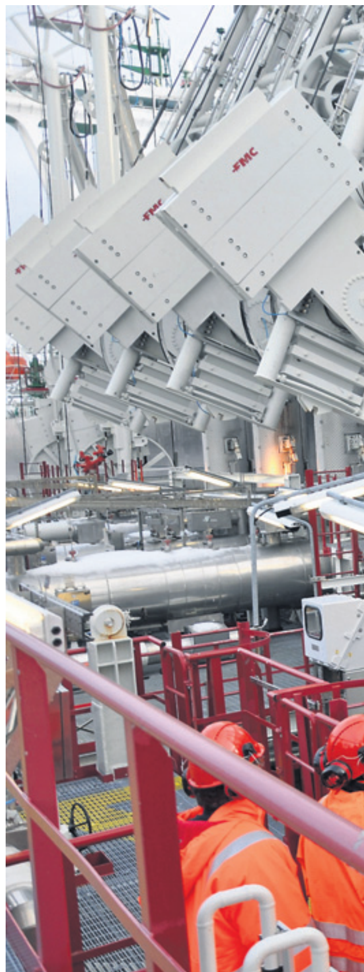
PÅ DEKK: Stor interesse for lasteinretningen for LNG. Legg merke til «vanne»
