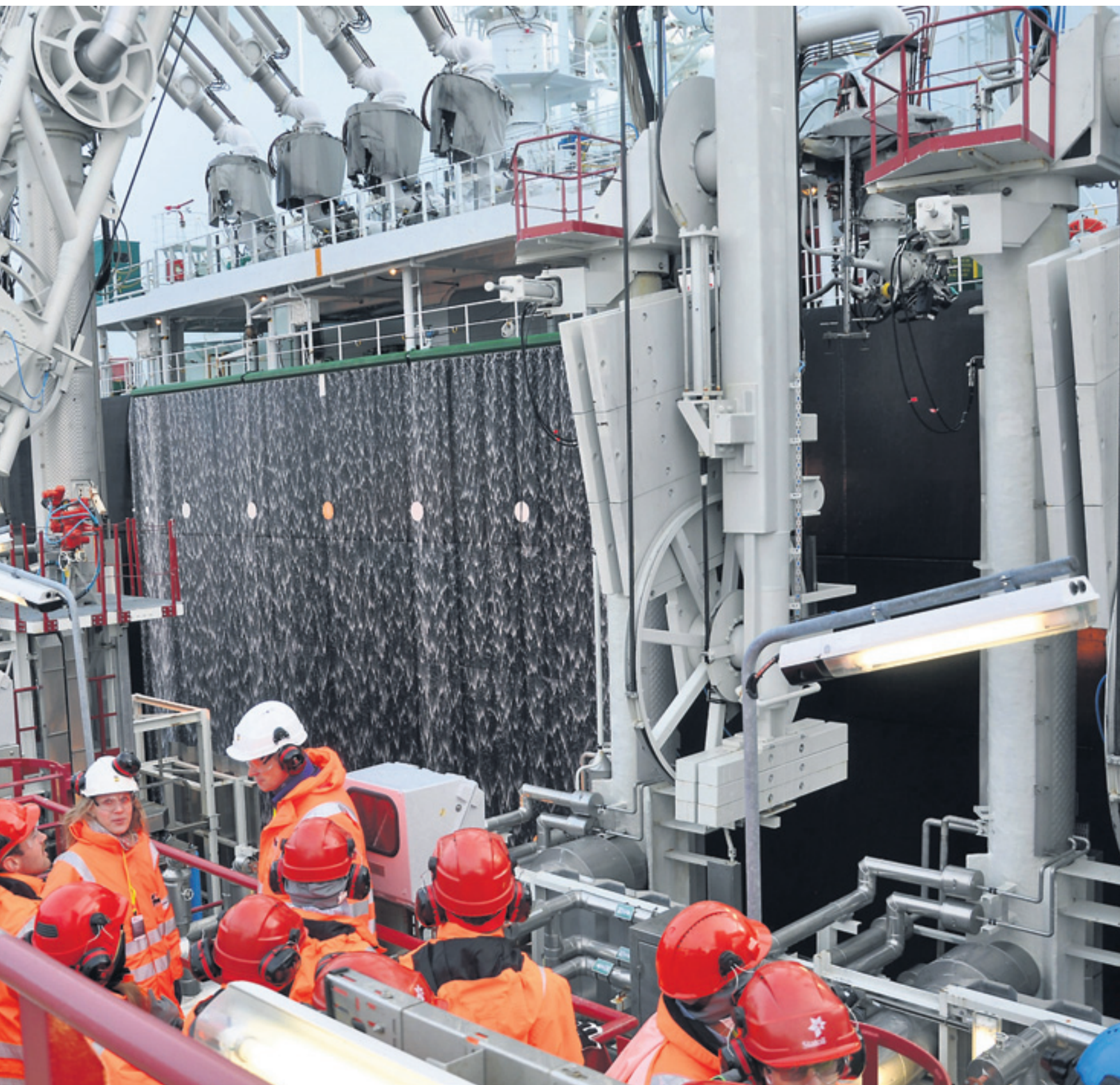
«fallet» på skipssiden. Det skal verne skipsstålet om det skulle bli en LNG-lekkasje som ville gitt en nedkjøling som stålet ikke ville tåle.
