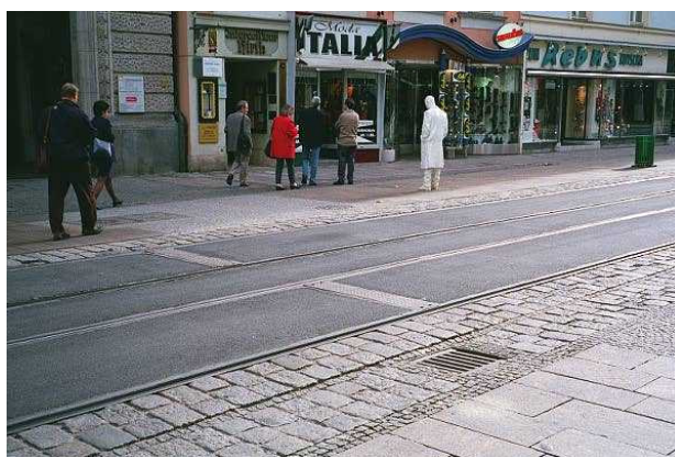
FIGUR 4.36 Gågate med trikkelinje der forskjeller i belegget angir de ulike sonene i gata
