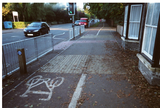
På delt gang- og sykkelvei skal riflene være i fartsretningen for syklistene og på tvers av fartsretningen for gående. Vi ser her at den langsgående opphøyde hvite skillelinja er lagt over det taktile belegget det ene stedet og ikke på det andre (Cambridge).
