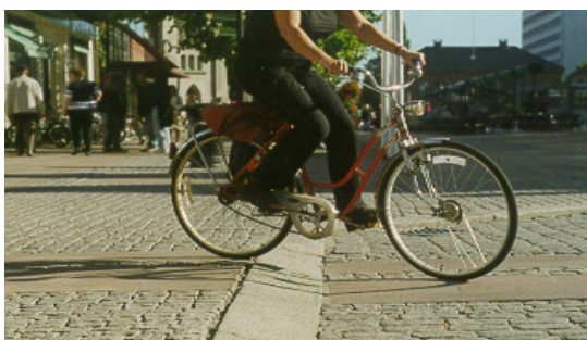
FIGUR 3.6 Skråstilt kantstein i gatekryss
