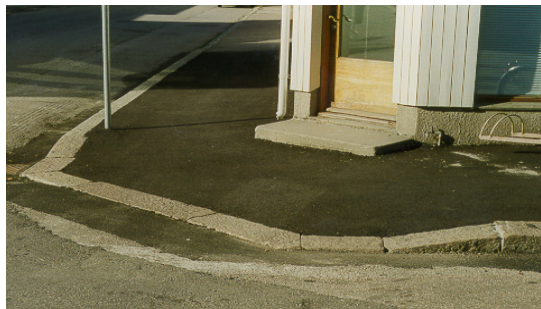
FIGUR 3.7 Nedsenking av kantstein og asfaltkile i gatekryss
