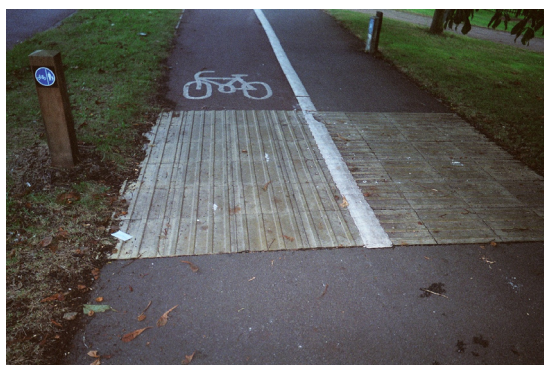
På delt gang- og sykkelvei skal riflene være i fartsretningen for syklistene og på tvers av fartsretningen for gående. Vi ser her at den langsgående opphøyde hvite skillelinja er lagt over det taktile belegget det ene stedet og ikke på det andre (Cambridge).
