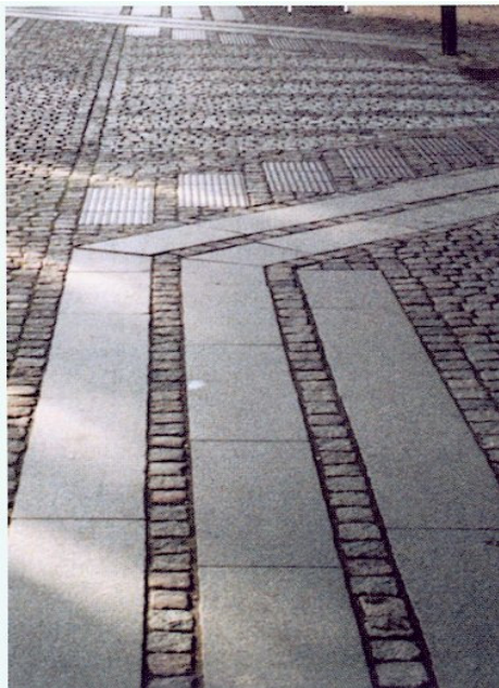
FIGUR 4.16 Gangbane utført med heller og gatestein /3/
