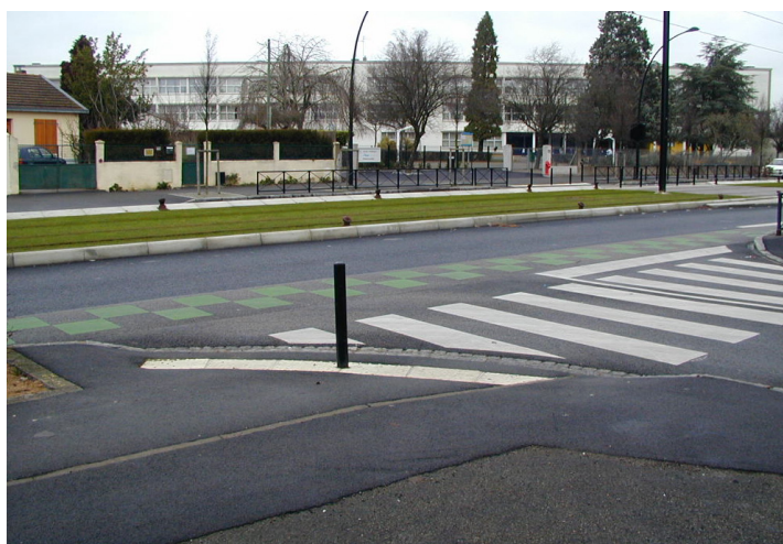
FIGUR 4.27 Plassering av varsellinje i kryss som gir feil retningsledning for blinde
