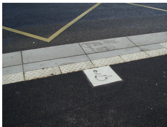
Varselflate langs fortauskant for lavgolvbuss. Rullestolmerket markerer hvor bussen stopper med dør for innstigning.
