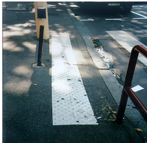
Slitasje på varselfelt med metakrylatharpiks /14/
