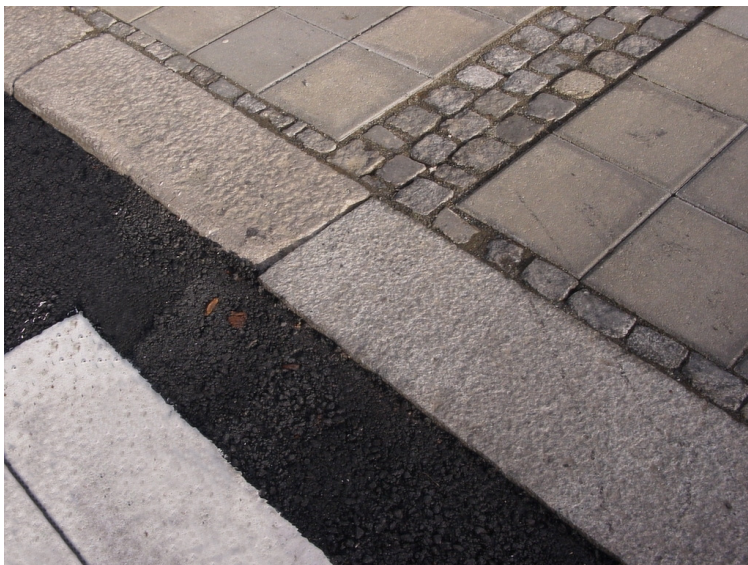
FIGUR 3.9 Avslutning av ledelinje inn mot fotgjengerovergang
