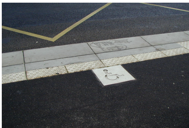
FIGUR 2.1 Taktile markering av bussholdeplass og påstigningssted (fremre dør) i Nantes, Frankrike
