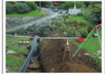
BORST 300 MED: Det ble boret 180 meter ned i jorden for å skaffe familien jordvarme. Prislapp med ledning til varmepumpe 180 000.
