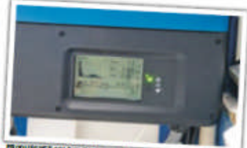
PRODUSERER SOLSTROM: En stasjon gir klar over produksjonen av solstikk på taket av miljøvennlige.
