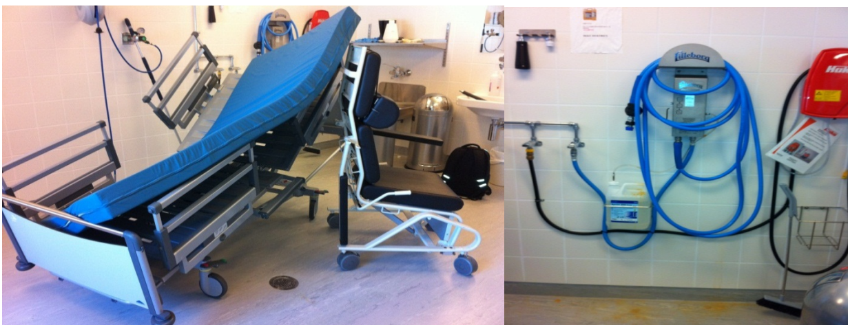
Figur 2 Desentralt vaskerom for rengjøring av ekstra skitne senger og smittesenger (før transport har smittesengene var innsatt med Virkon). Vannslangen har normalt trykk. Det er trykk luft for tørking av sengen, men den er lite funksjonell ettersom den ikke har større trykk enn en hår-tørker". Sluket har feil helling, og vannet renner ut i rommet.
