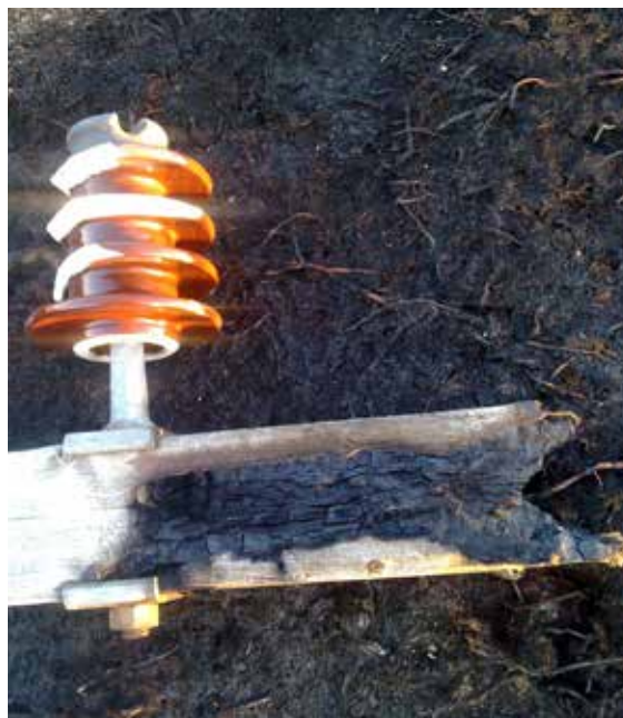
Ulmebrann i en 22 kV travers i H-mast med forsterket oppheng etter at traversen ble lagt på høyspenning i motsatt ende. (Foto: Per Christian Berntsen)
