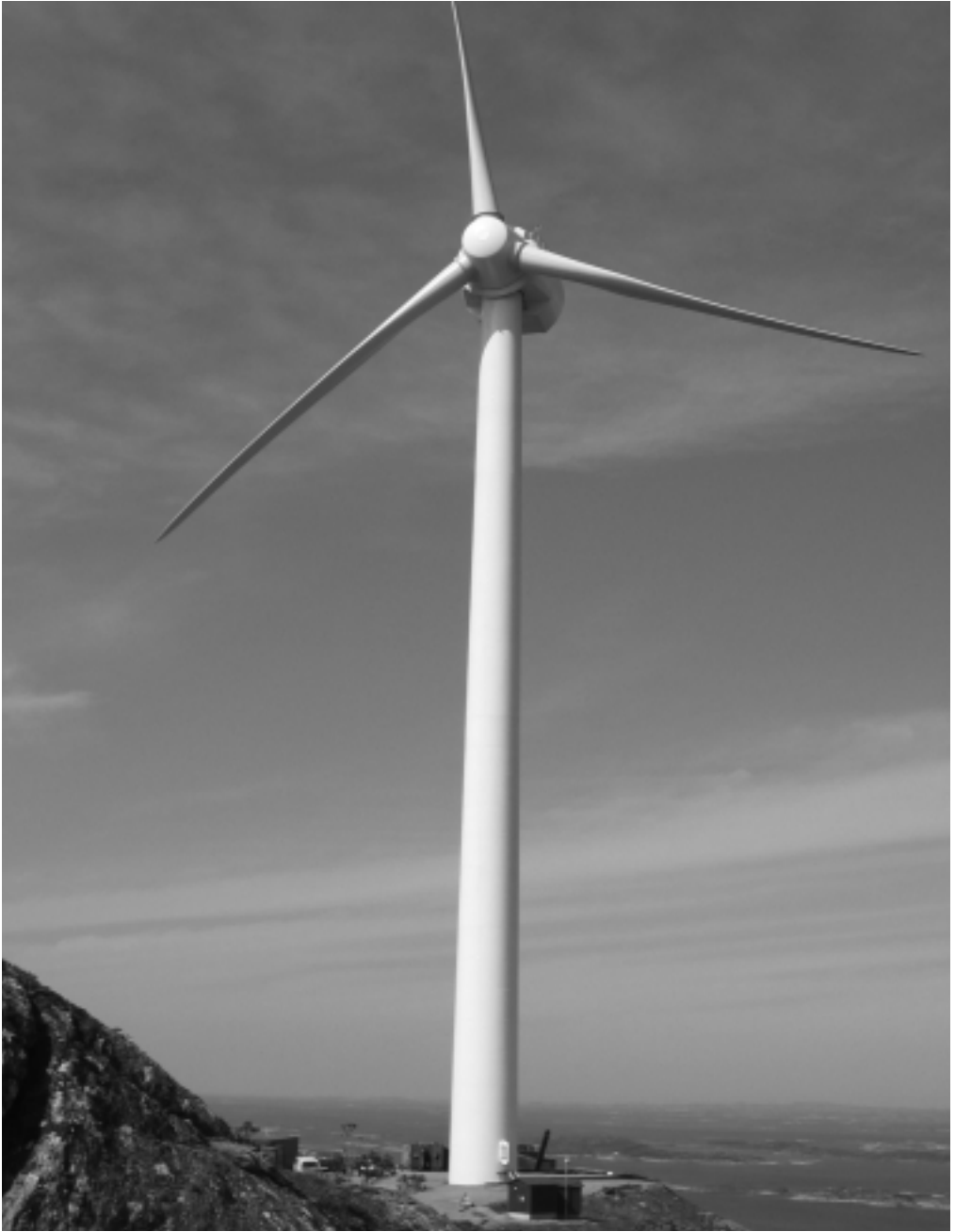
Figur 3: ScanWind 3 MW vindturbin (tårnhøyde 83 m) installert på Hundhammerfjellet i Nord-Trøndelag. Foto gjengitt med tillatelse fra ScanWind AS.
